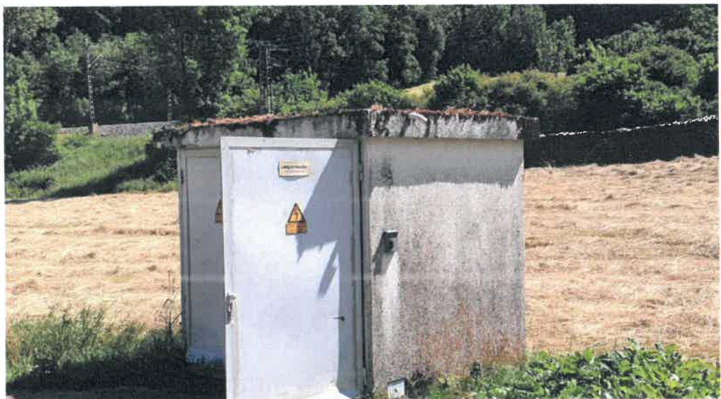
Abbildung 1: MS-Kompaktstation inkl. Trafo
