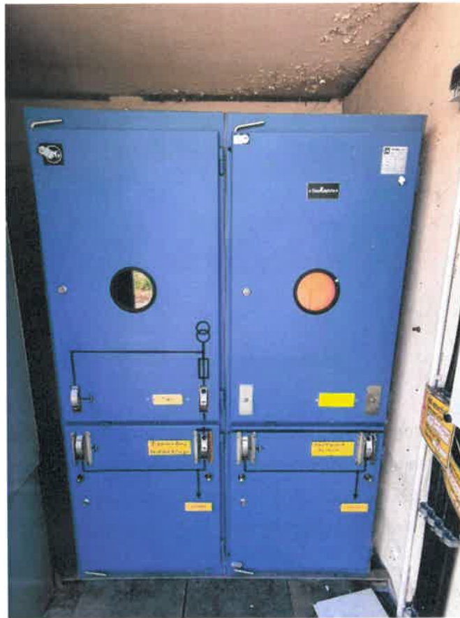
Abbildung 5: Mittelspannungsschaltanlage
